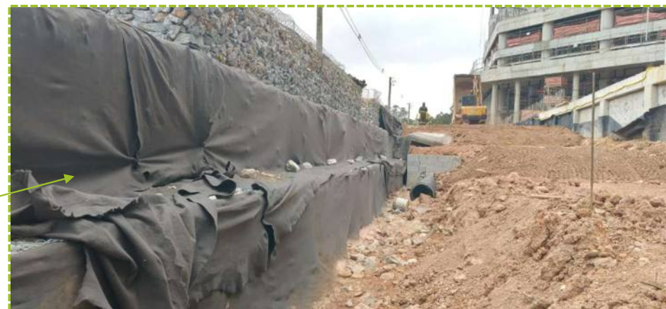
Paramento com manta simples
